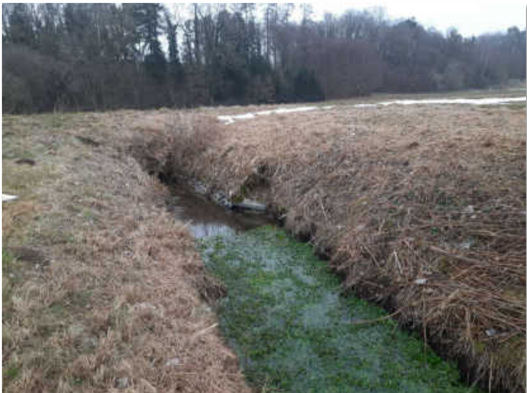
Einleitstelle Mulde Ellzeer Str. in Gewässer
