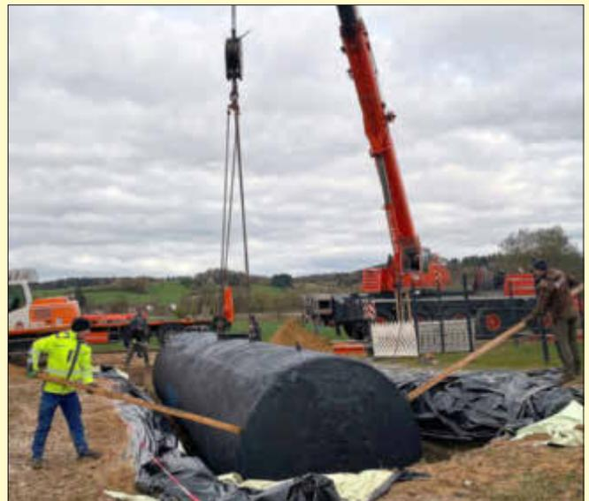
Zur Sicherstellung der Löschwasserversorgung hat der Markt Neuburg a. d. Kammell im neuen Industriegebiet einen Löschwassertank mit 60 Kubikmetern Fassungsvermögen verbaut.
