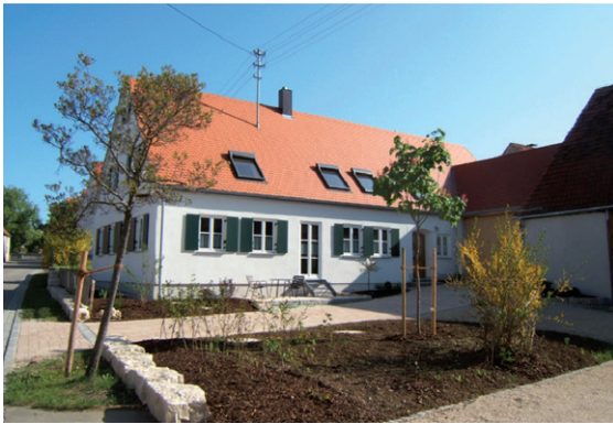
◆ Forheim, Landkreis Donau-Ries - Dorfgerechter Ersatzbau in Holzbauweise
