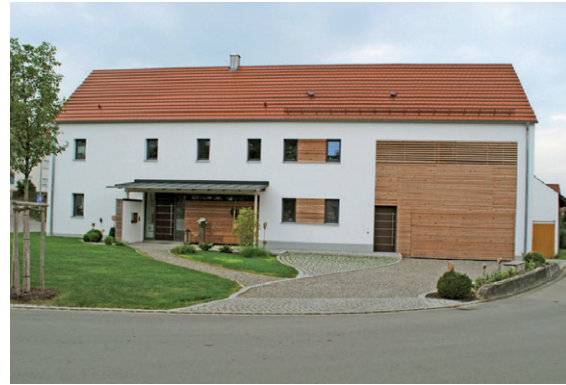
◆ Münsterhausen, Lkr. Günzburg - Ersatzbau für ein- sturzgefährdeten Bauernhof
